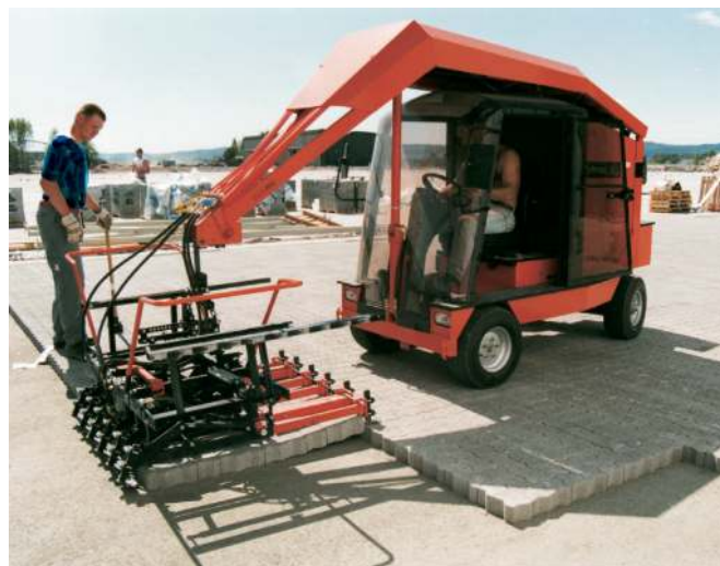
Maskinlægning med løftetang på specialmaskine, kan også monteres på minigraver, minilæsser mv.
