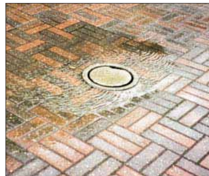
Lunker der giver vandsamlinger skal rettes op.
